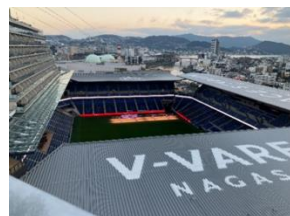
図31 サッカー場 屋上
